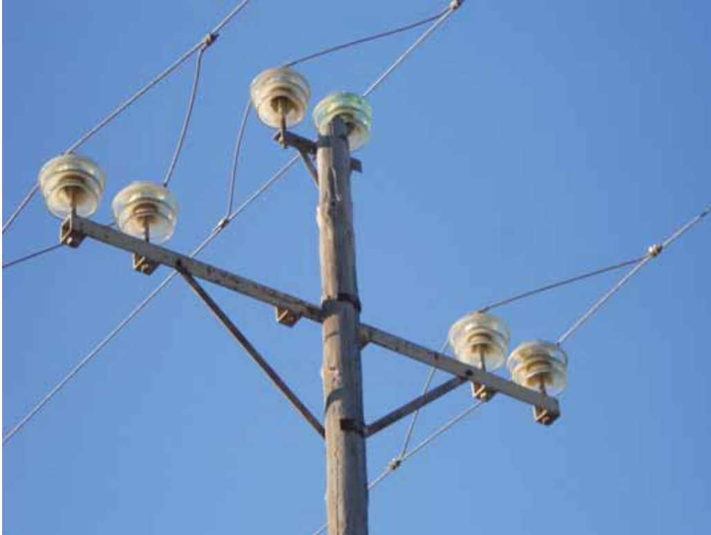
Imatge 22: Exemple de bona col·locació de cables per sota el nivell de la torre
